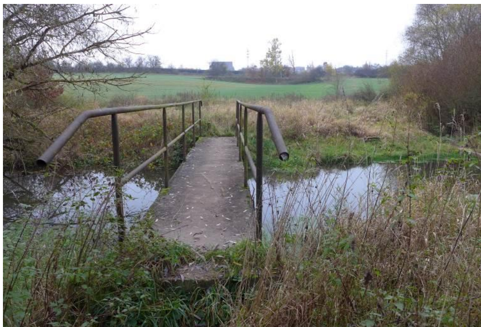
Jediná možnost dostat se suchou nohou na pravý břeh potoka.
